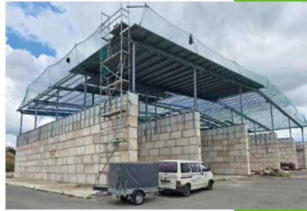
Neubau der Halle der Nordmineral, 2022
