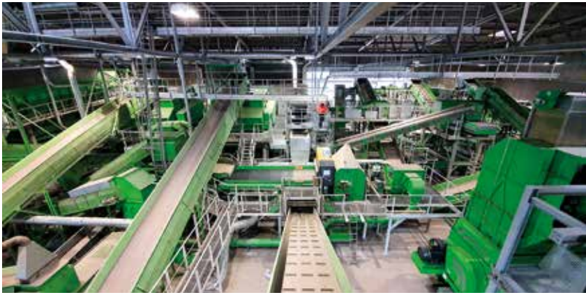
Anlage Lockwitz – Ansicht der Maschinenhalle
