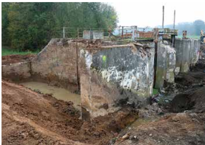
Abriss alter Wehrkörper, 2019
