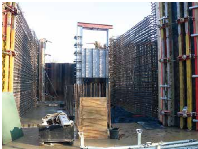
Schalung und Bewehrung, 2020
