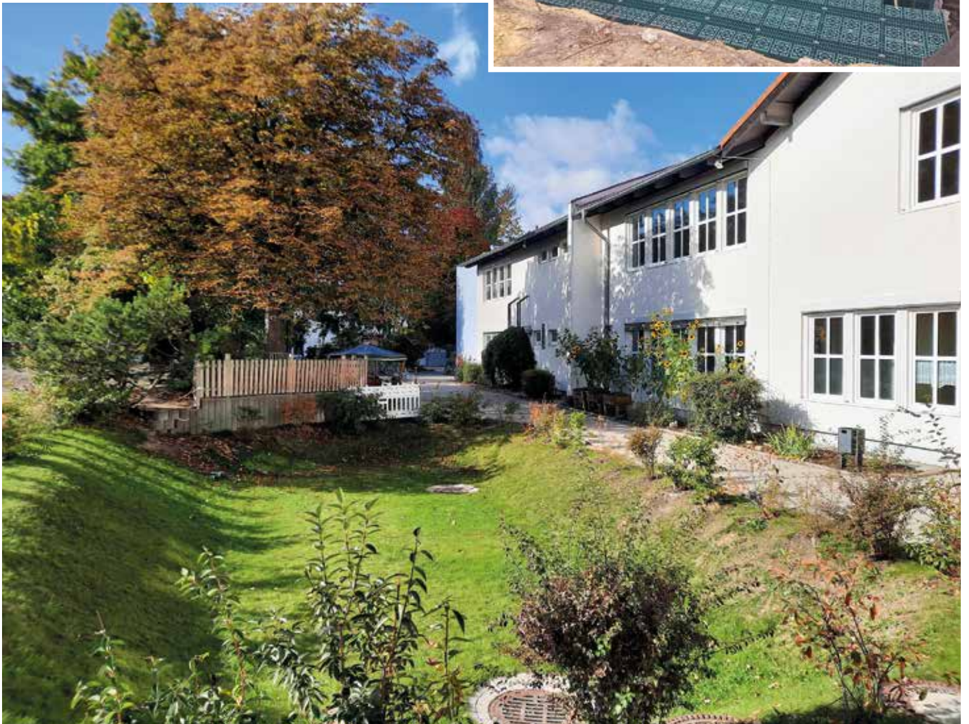
Multifunktionale Regenwasserrückhalte- und Versickerungsanlage der Regenbogenschule in Taucha (Fotos: Stadtverwaltung Taucha) rechts: Bauwerkseinbau / unten: Fertige Anlage im Oktober 2022
