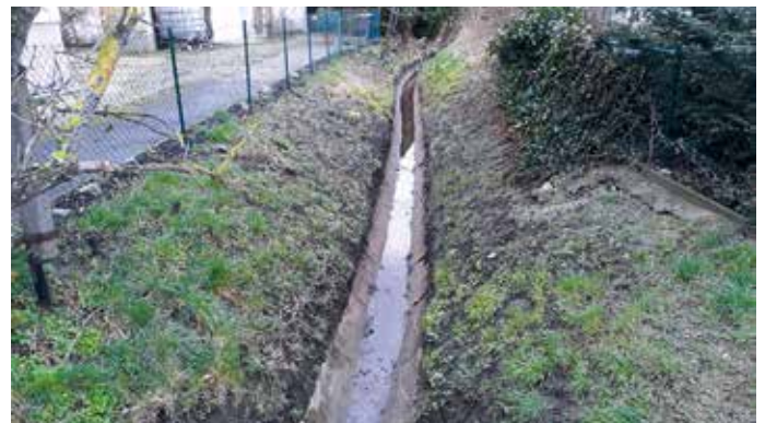
Menschliche Überprägung von Gewässern: in Betonelementen geführtes Gewässerprofil am Sommerfelder Graben
