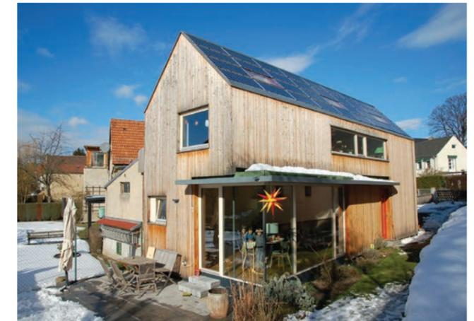
Indach-Photovoltaikanlage auf kompletter Süddachfläche eines Wohnhauses in Dresden-Hellerau, Architekt: Rentzsch Architekten, Foto: Olaf Reiter
