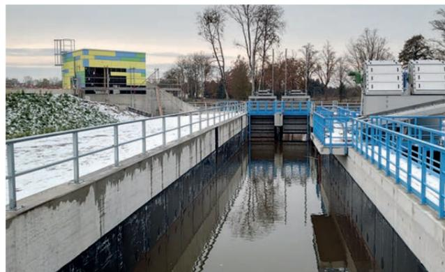
Eine Lösungsmöglichkeit für diesen Fall ist eine konventionelle chemische Eisenoxidation in entsprechenden Wasserbehandlungsanlagen. Daher wird im Auftrag der Lausitzer und Mitteldeutschen Bergbau-Verwaltungsgesellschaft mbH (LMBV) in der Ortslage Plessa eine neue Wasserbehandlungsanlage (WBA) mit einer Aufbereitungskapazität von max. 5.760 Kubikmeter/Stunde errichtet. Die jährlich gereinigte Wassermenge wird etwa 33 Mio. Kubikmeter betragen.
