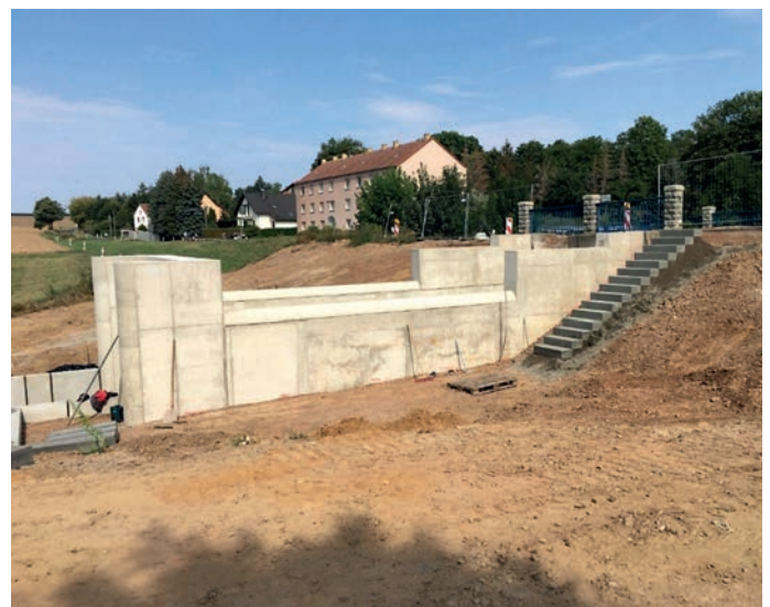
Neue Hochwasserentlastung nach der Betonage
