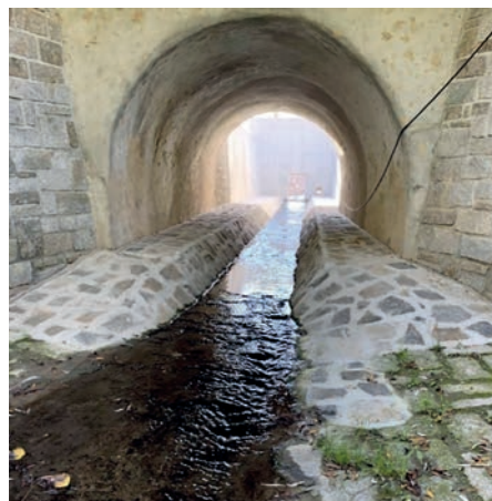
Instandgesetzter Durchlass unter der Brücke
