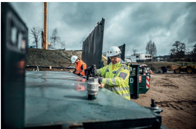
Kontaminiertes Material wird in gasdichten Containern abtransportiert und entsorgt.
