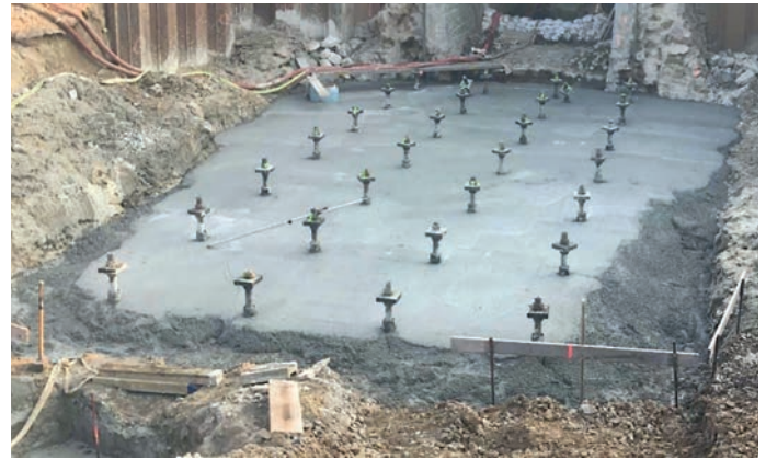
Baugrubensohle mit Ankern
