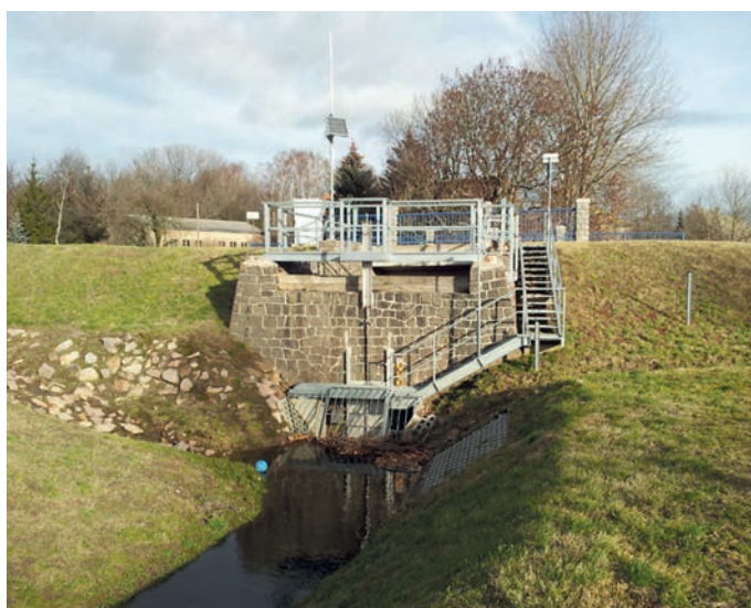
Alte Hochwasserentlastung vom Beckenraum gesehen
