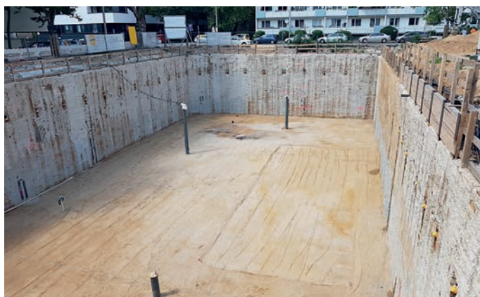
Abb. 1: Verankerte Baugrube mit MIP-Verbauwand
