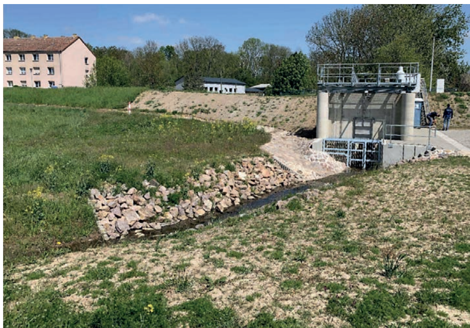
Abschluss der Bauarbeiten
