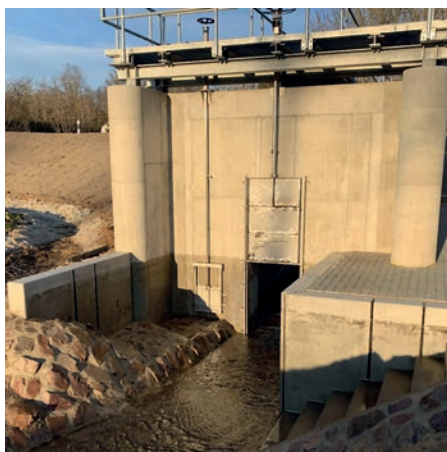
Drosseldurchlass mit Plattenschieber
