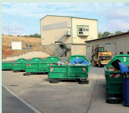
Wertstoffhof und Umladestation Kleincotta
