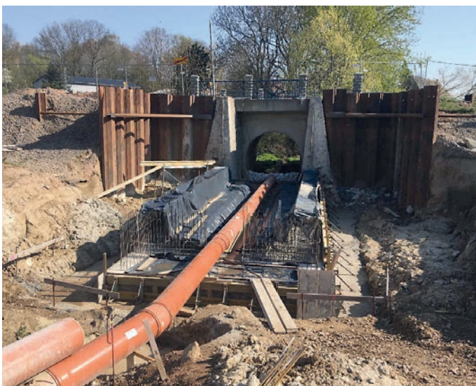
Betonarbeiten an der Hochwasserentlastung
