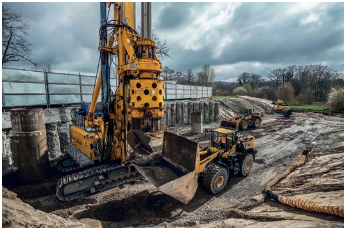
Insgesamt werden rund 3.500 m 3 Erde ausgehoben und 6.000 m 3 schadstoffbelastetes Bodenmaterial in bis zu 15 m Tiefe mittels Großlochbohrungen ausgetauscht.
