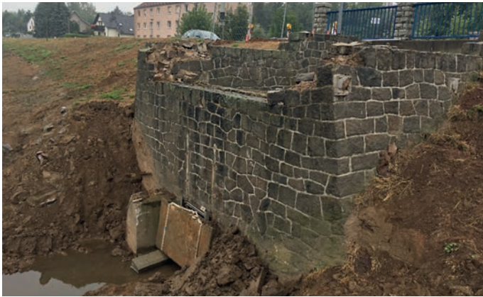
Abbrucharbeiten an der alten Hochwasserentlastung
