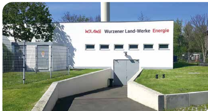
Heizwerk der Wurzener Land-Werke Energie GmbH in Wurzen (Foto: Wurzener Land-Werke)
