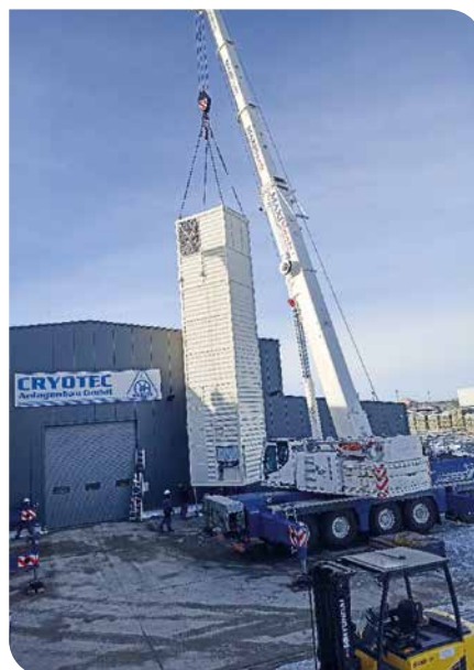
Aufstellen der Cold Box
