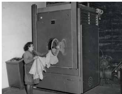
Trofix = schonende maschinelle Trocknung von Fellen im Luftstrom mit Abluftrückgewinnung
