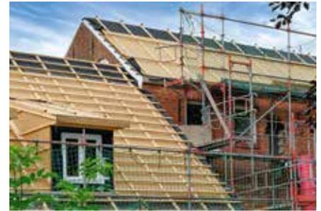
ersetzt die herkömmliche Dacheindeckung. Gleichzeitig fungiert sie als wasserführende Schicht, die Strom produziert.
