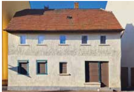
Markkleeberg, Koburger Straße
