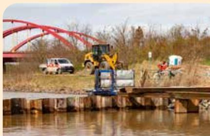
Der Baufortschritt oberhalb der Kanuparkschleuse auf Störnthaler Seeseite ist sichtbar: Am 1. April 2021 konnte die erste stählerne Spundwandachse des oberen Spundwandriegels kurzfristig fertiggestellt werden. Nachdem am 29. März 2021 die Baggerarbeiten im Wasser begonnen hatten, wurden seit zwei Tage später die einzelnen Spundwandprofile gesetzt. ... **MSJ 08/2021**
