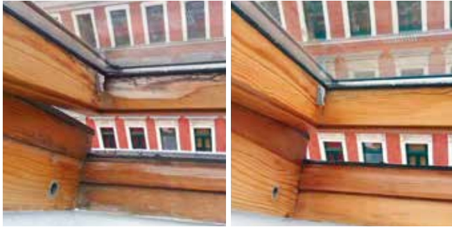
Vor und nach der Sanierung eines Dachflächenfensters
