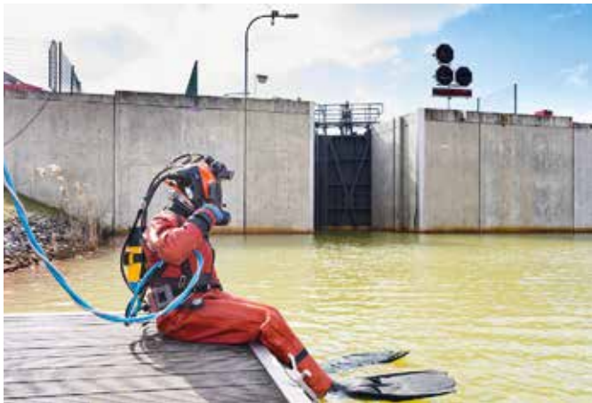
Tauchinspektion an der Schleuse. (Foto: LMBV/Anika Dollmeyer)
