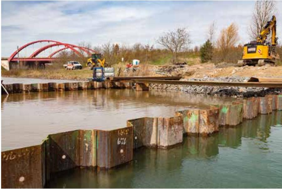
Der Raum zwischen den beiden Spundwänden wird mit Erdreich und Wasserbausteinen ausgefüllt, um so den Störmthaler Kanal abdichten zu können.
