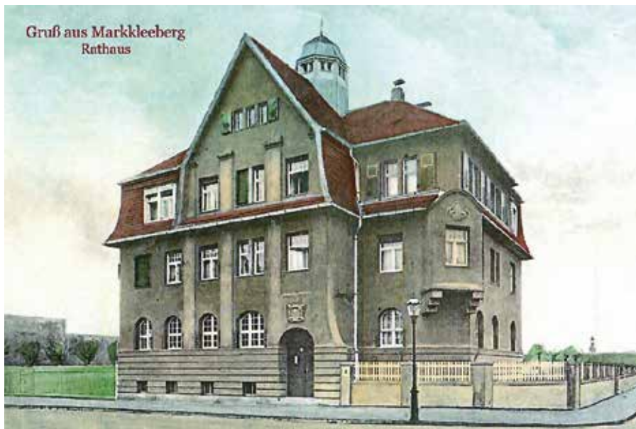
Das ehemalige Rathaus in der Bornaischen Straße (Markkleeberg-Ost)
