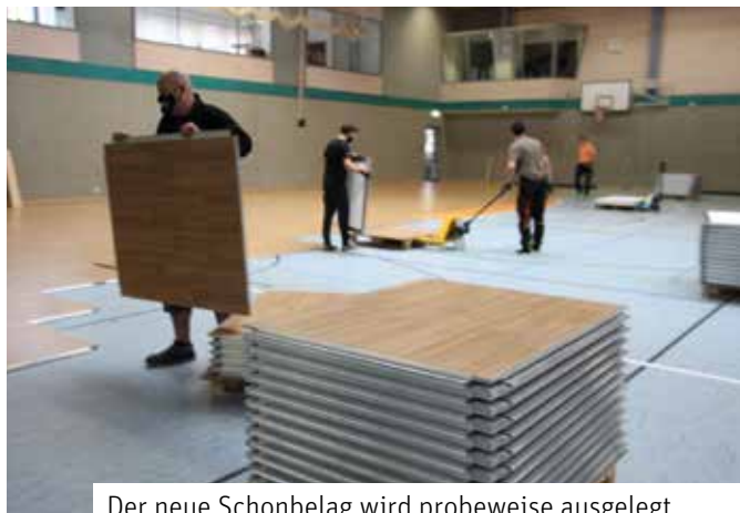
Der neue Schonbelag wird probeweise ausgelegt.
