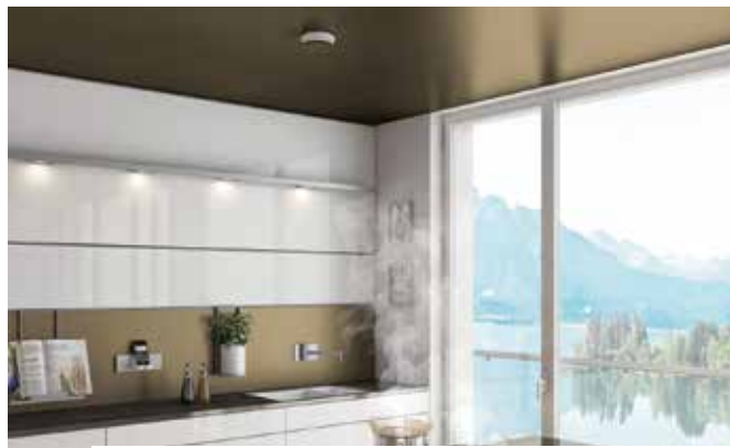
Rund 125.000 Schäden gehen jährlich von der Kochstelle im Haus aus. Ein Herdwächter macht sie sicher. (Foto: djd/Elektro+/Jung)
