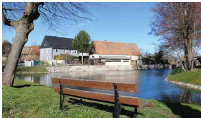
Foto 5: Blick auf die sanierten Dorfteiche in Colmnitz
