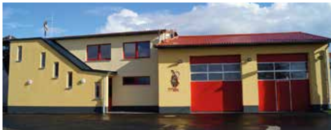
Foto 7: Außenansicht des Feuerwehrgerätehauses in Skaup
