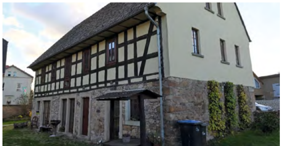
Das Seitengebäude im Jahr 2001 vor der Sanierung (oben) und heute
