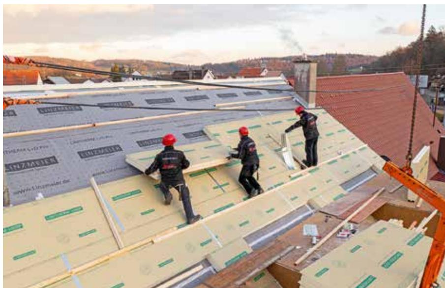
Eine Aufsparrendämmung wird auf dem Dach montiert.
