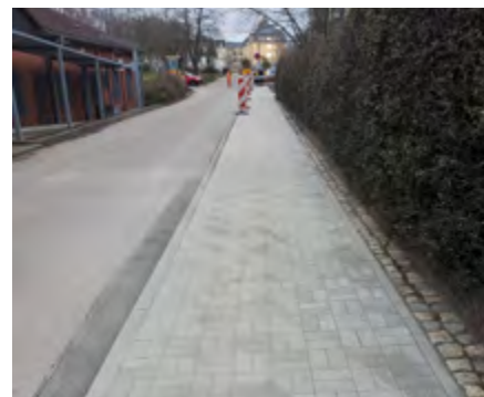
Der sanierte Gehweg in der Oststraße
