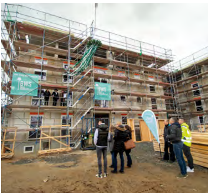
Richtfest am Neubau in der Stauffenbergstraße
