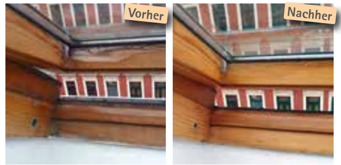
Vor und nach der Sanierung eines Dachflächenfensters.
