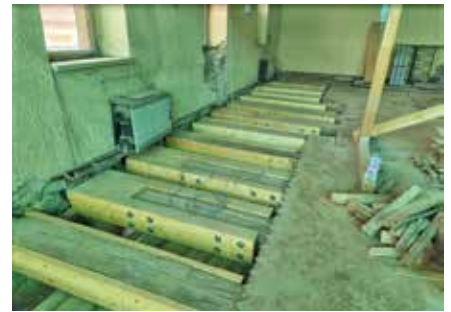
Fast alle Balken im Dachgeschoss mussten verstärkt werden.
