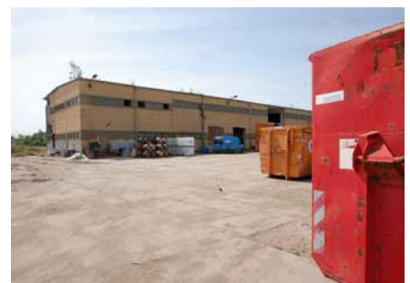
Die ehemalige Lagerhalle beherbergt noch rund 180 Tonnen chemische Altlasten
