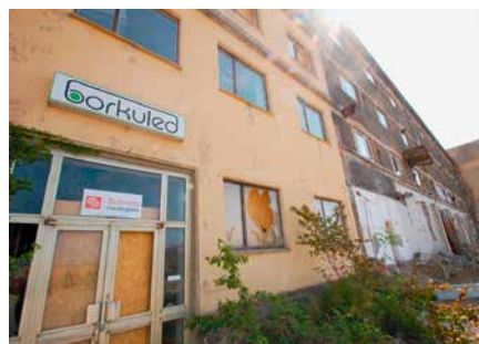
In zehn der einstigen Fabrikgebäude sollen Loftwohnungen entstehen
