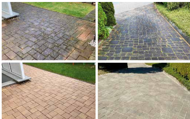
Zwei Steinflächen jeweils vor (oben) und nach der Sanierung (unten).
